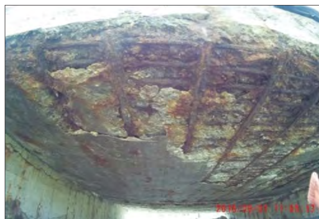
Рис. 5. Пролет пешеходного моста Холмского морского торгового порта Fig. 5. Span of the pedestrian bridge of the Kholsmsk sea trade port
